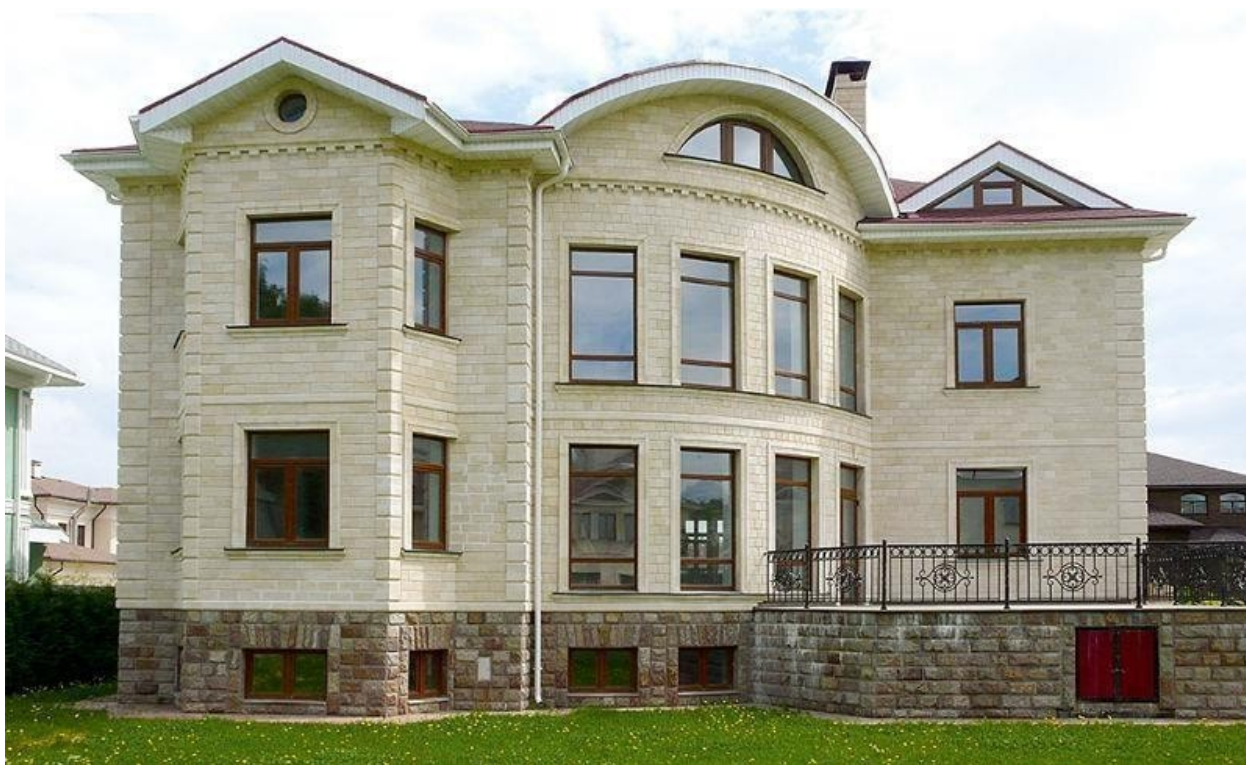
Рисунок 14 – Облицовка здания доломитом
