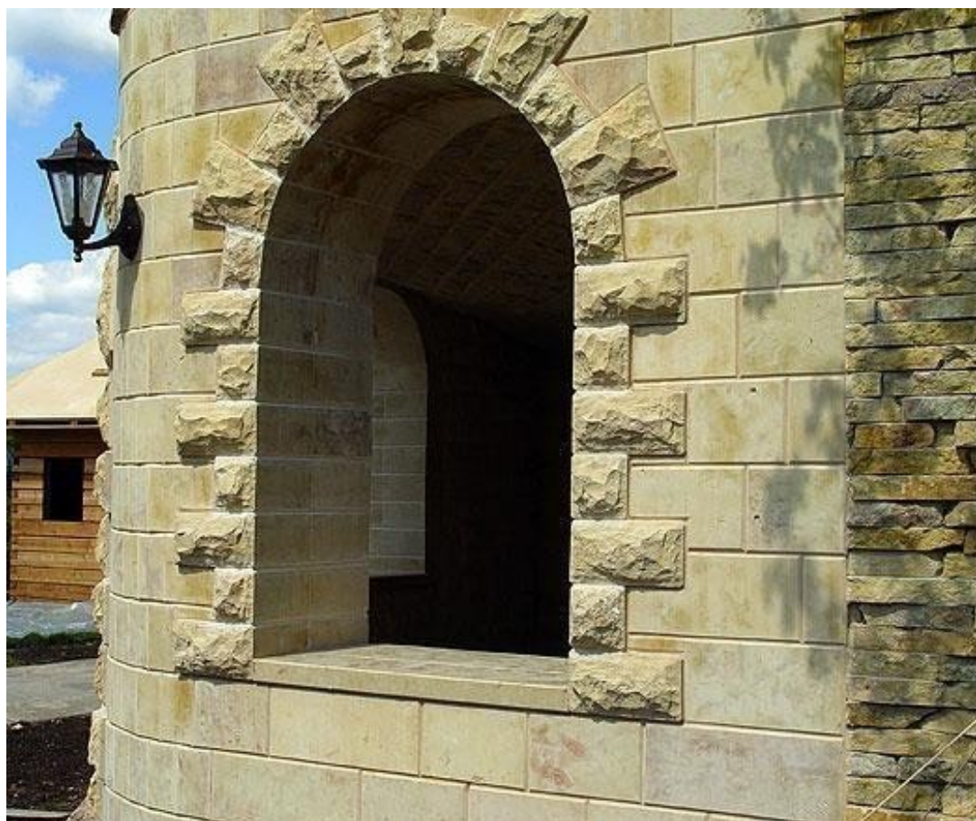
Рисунок 13 – Облицовка здания доломитом
